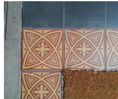
Fliesen im Eingangsbereich bis 2020.
