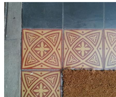
Fliesen im Eingangsbereich bis 2020.
